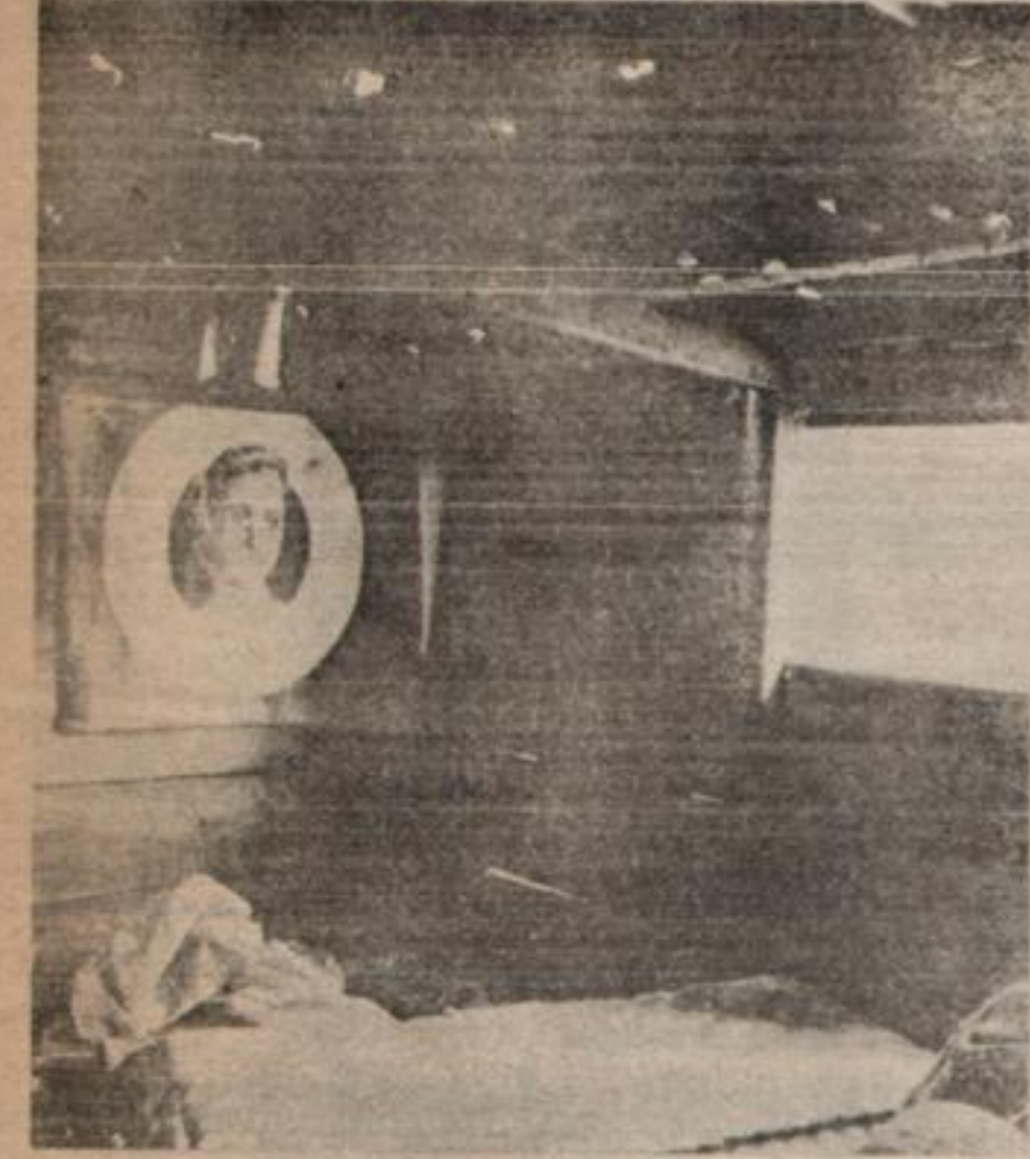
Los techos quedaron como un "colador". Drama de todos los días.
