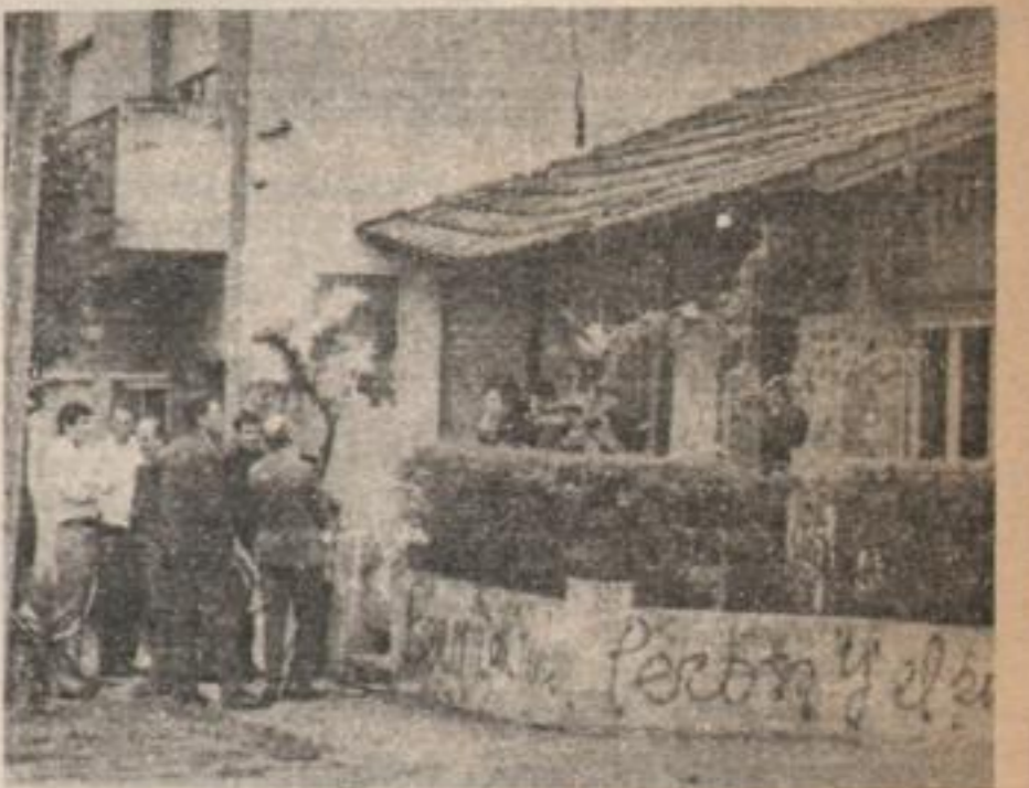
Destrozos en la puerta de la UB.
