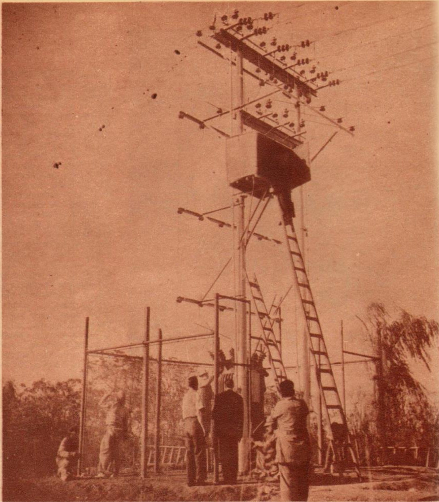
Cercana a una ciudad se levanta esta torre transformadora que reduce el voltaje para que pueda ser utilizada.
