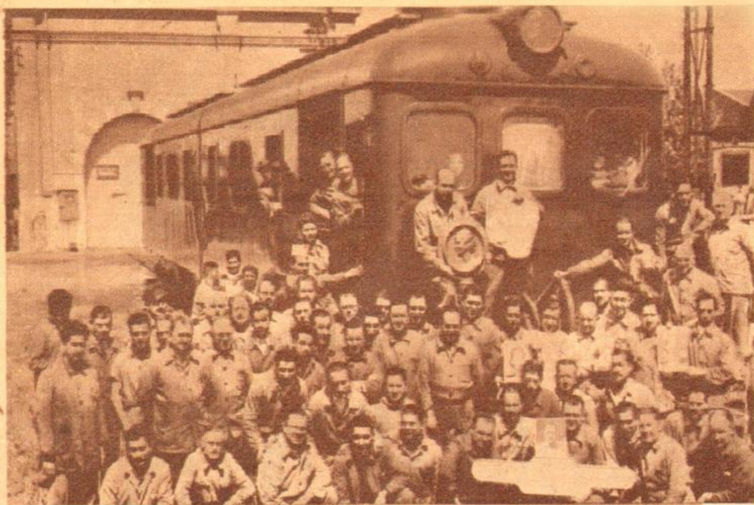
Y aquí presentamos al grupo de obreros con el producto de sus manos y de su entusiasmo, la Usina Móvil (U. E. 6), en los talleres de Remedio de Escalada.
