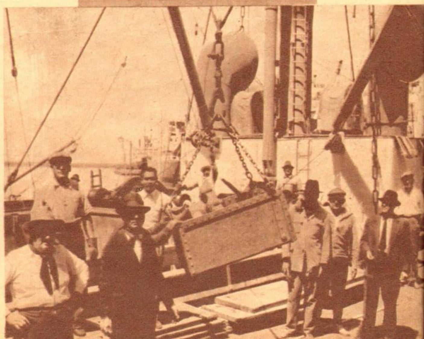
Una vez completada la carga, el guinche la lleva hacia tierra en ascendente trayectoria.
