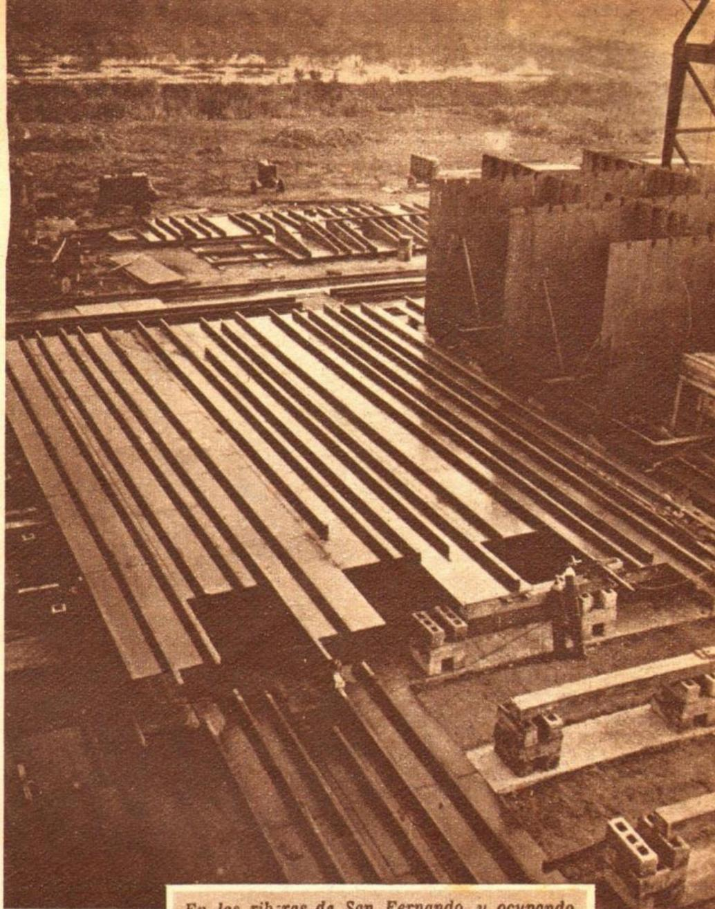
En las riberas de San Fernando, y ocupando una extensión de casi cuatro manzanas, se van soldando las chapas de acero del dique flotante que necesita nuestra poderosa flota de ultramar para sus reparaciones.
